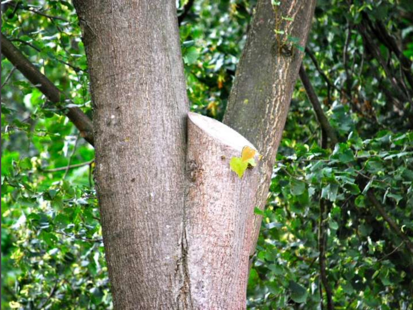
Rechtopgaande dikke tak afgezaagd (zie ook volgende foto)
